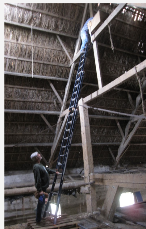
Het controleren van een kast...
